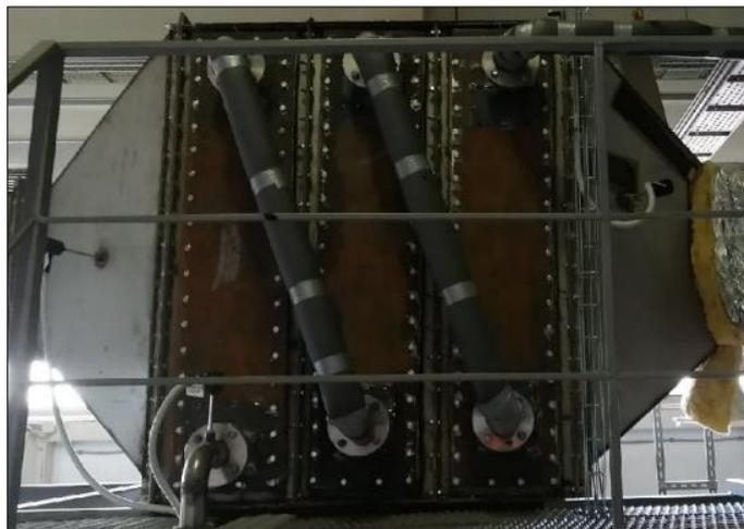
**Рис. 1. Рекуперативный теплообменный аппарат на промышленном предприятии**
